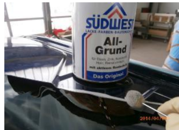
Bild 10.3 Grundieren
